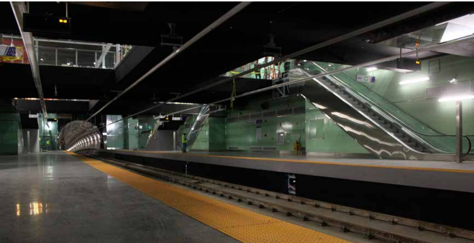
Imagen de estación subterránea de la Línea 1 del Metro de Panamá
