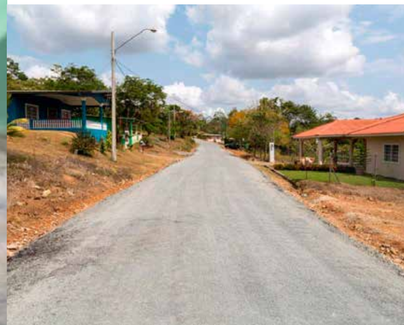
Rehabilitación de la calle principal de la barriada "El Periodista"
